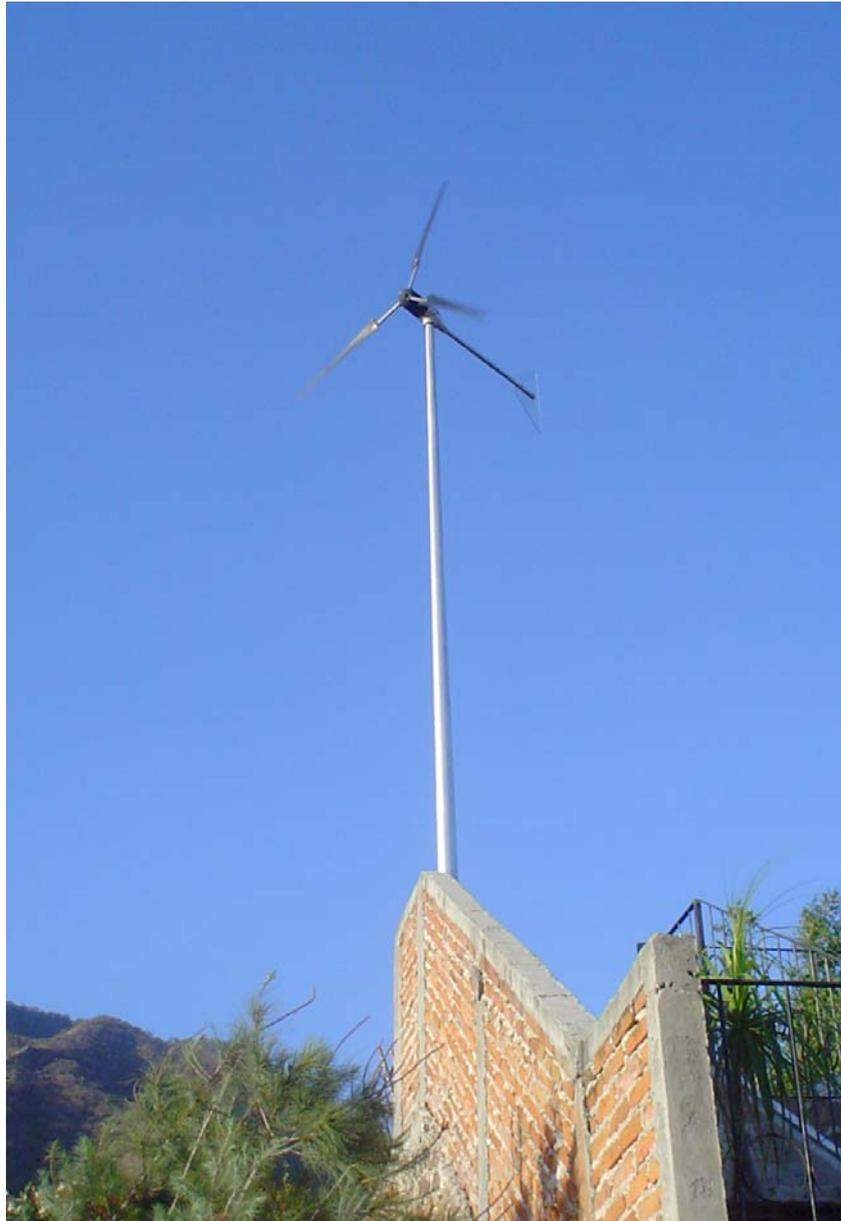
Las turbinas eólicas convierten la energía del movimiento del viento (energía cinética) en energía mecánica (movimiento sobre un eje). En los generadores de la turbina, ésta energía mecánica se convierte en electricidad.
